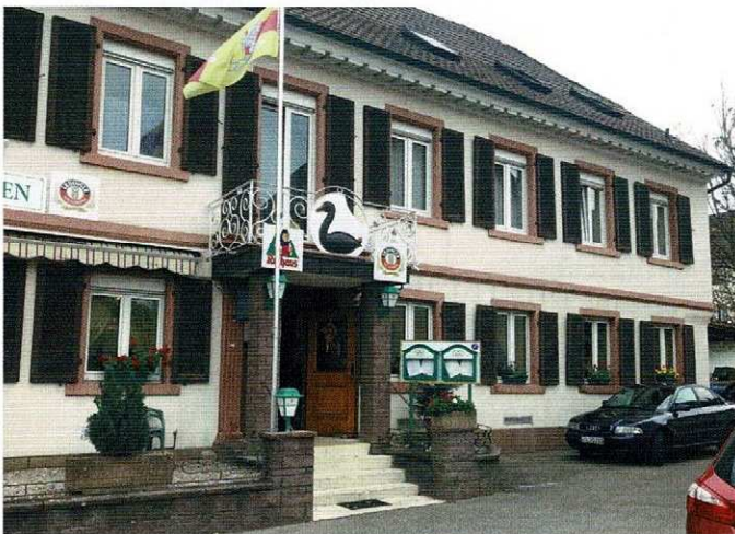
Die Fassade vom Hotel Restaurant Schwanen war verwittert und unauffällig.
